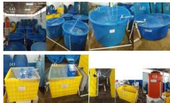
Gambar 2. (a) Fasilitas pengujian sistem RAS dan air mengalir (FT) untuk pemeliharaan lobster. (b) Bak pemeliharaan lobster RAS; (c) Bak pemeliharaan lobster sistem air mengalir (FT) dan (d) bak sedimentasi; (e) Kompartemen filter mekanis dan (f) filter biologis; (g) UV sterilizer, (h) kompartemen degasser CO<sub>2</sub> dan (i) tandon air bersih.
